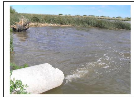
Foto N° 5.5: foto descarga de efluente cloacal tratado en el río
