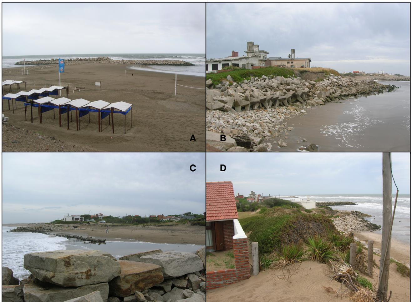
**Figura 5. a)** Vista de la vivienda de la unidad de análisis 14, la cual se encuentra rodeada por médanos. **b)** Vista desde la marea baja. Puede observarse la estructura construida por el propietario para defender la vivienda y reconstruir el médano frontal, ya que la misma es alcanzada por mareas de tormenta.
