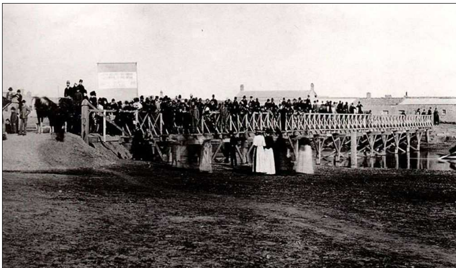
Figura 7: Panorámica del Puente de madera y tierra sobre el Río Chubut (véase sobre el extremo de la foto un viejo botero)
