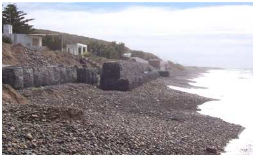
Figura 25: Obras de protección en Playa Magagna
