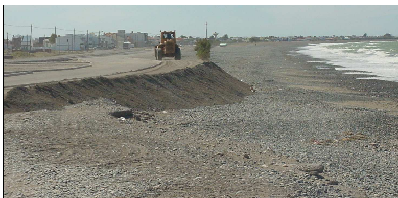
Figura 22: Obras de protección de la Av. Costanera
