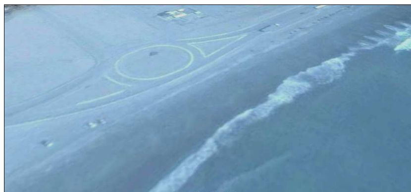
Figura 14: Avance de la Avenida Costanera sobre la playa
