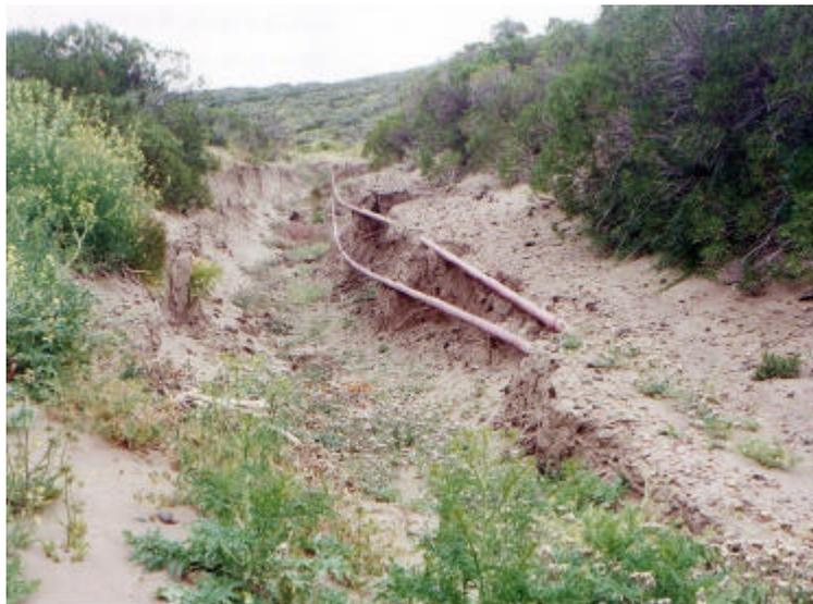
**Fig. 6:** Erosión hídrica en la traza de un ducto.
